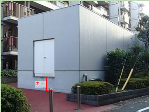
写真2 地盤の沈下
