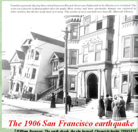
写真1 建物の沈下傾斜
