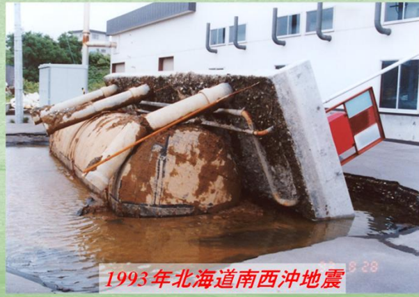
写真3 地中埋設物の浮き上がり
