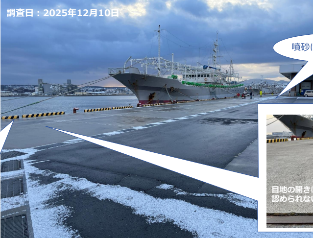
LP-LiC施工箇所
