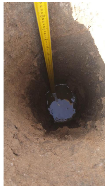
動画：施工時のオーガ孔での水位確認状況
