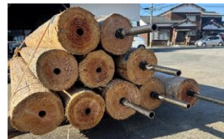
写真：継手加工状況
