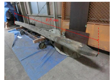
東京丸の内駅舎基礎 (約100年前)
